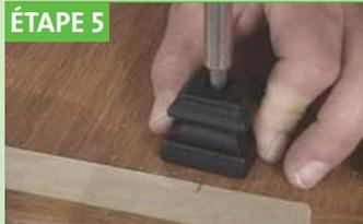
À l'aide de la clé Allen, détendre la vis de serrage à la base du nouveau barreau et séparer la base du barreau. Appliquer l'adhésif de construction sous la base, aligner avec la marque et visser dans la marche. Insérer l'autre partie du barreau dans la base.
