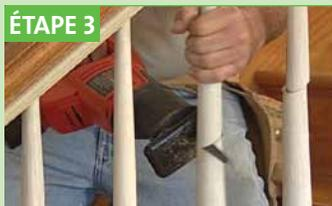
Couper et retirer les barreaux originaux et remplacer par les nouveaux, 4 ou 5 à la fois afin de maintenir le support de la rampe tout au long de l'installation des barreaux.
