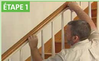
Appliquer le ruban à masquer sur le côté de la rampe et à la base des barreaux existants pour marquer le centre de chacun des barreaux.
