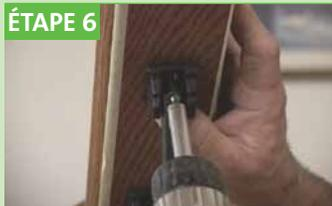
Appliquer l'adhésif de construction sur la surface plane de la tête pivotante. Allonger la tige télescopique du nouveau barreau jusqu'à la rampe et fixer solidement à l'aide de 2 vis.
