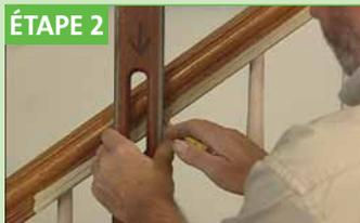
À l'aide d'un niveau, marquer le centre des barreaux originaux dans le haut et dans le bas de chacun.
