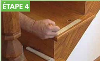
Une fois les barreaux existants retirés, marquer le centre des barreaux originaux sur le ruban à masquer.
